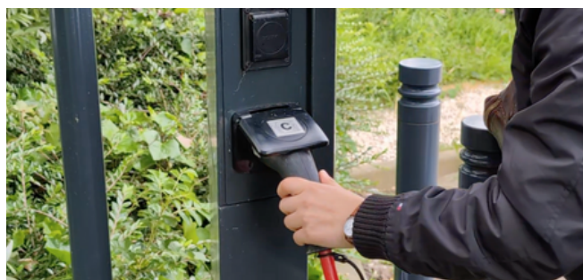
Je le branche côté station
