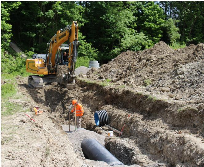
Une nouvelle phase du chantier s'engage : les premiers travaux de terrassement, voirie et réseaux. La société Colas est chargée de créer les réseaux d'assainissement, d'électricité et de gaz. Vient ensuite l'étape de la voirie.
