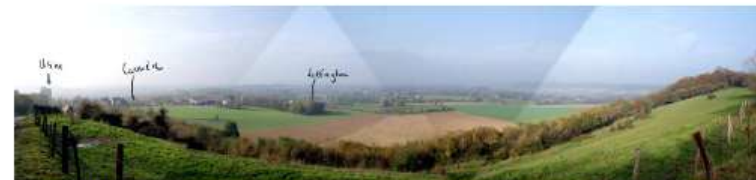
Vue 5 - Depuis la route qui monte sur le plateau. Cimenterie en belvédère sur le territoire.
