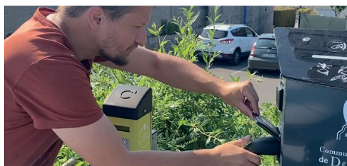
Je branche côté station
